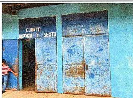
Foto 5: Puertas de las aulas en mal estado requieren cambio
