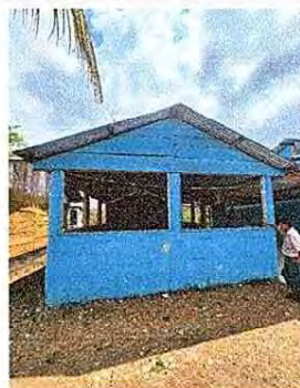
Foto 4: Cambio de Cubierta de lamina
