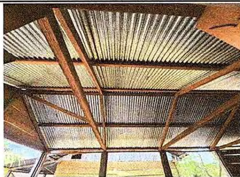
Foto 2: Sustitucion de entrectura de techo por metal y cubierta de lamina
